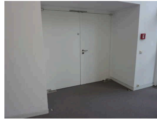
Tür zum Veranstaltungsraum (UG)
