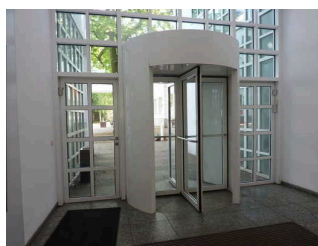
Türen im Eingangsbereich
