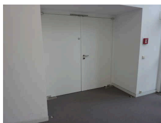
Tür zum Veranstaltungsraum (UG)
